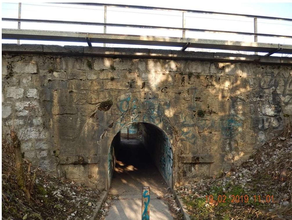
Slika 1: Pogled na objekt. Viden so kamniti krilni zidovi ter lok. Vidna je tudi izvedba novega betonskega loka pod obstoječim.
